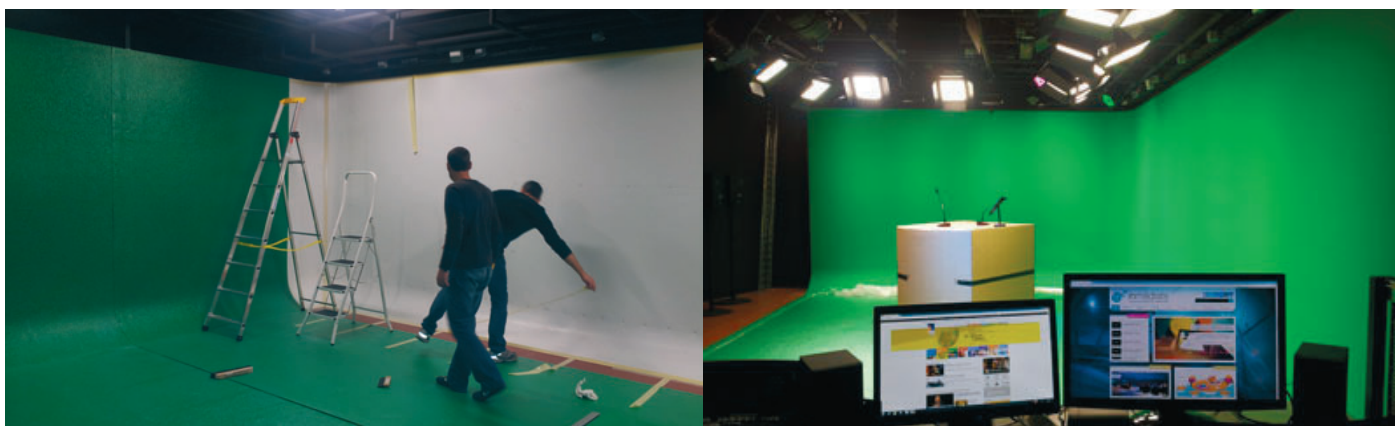
Réalisation du StudioLab, avant/après
