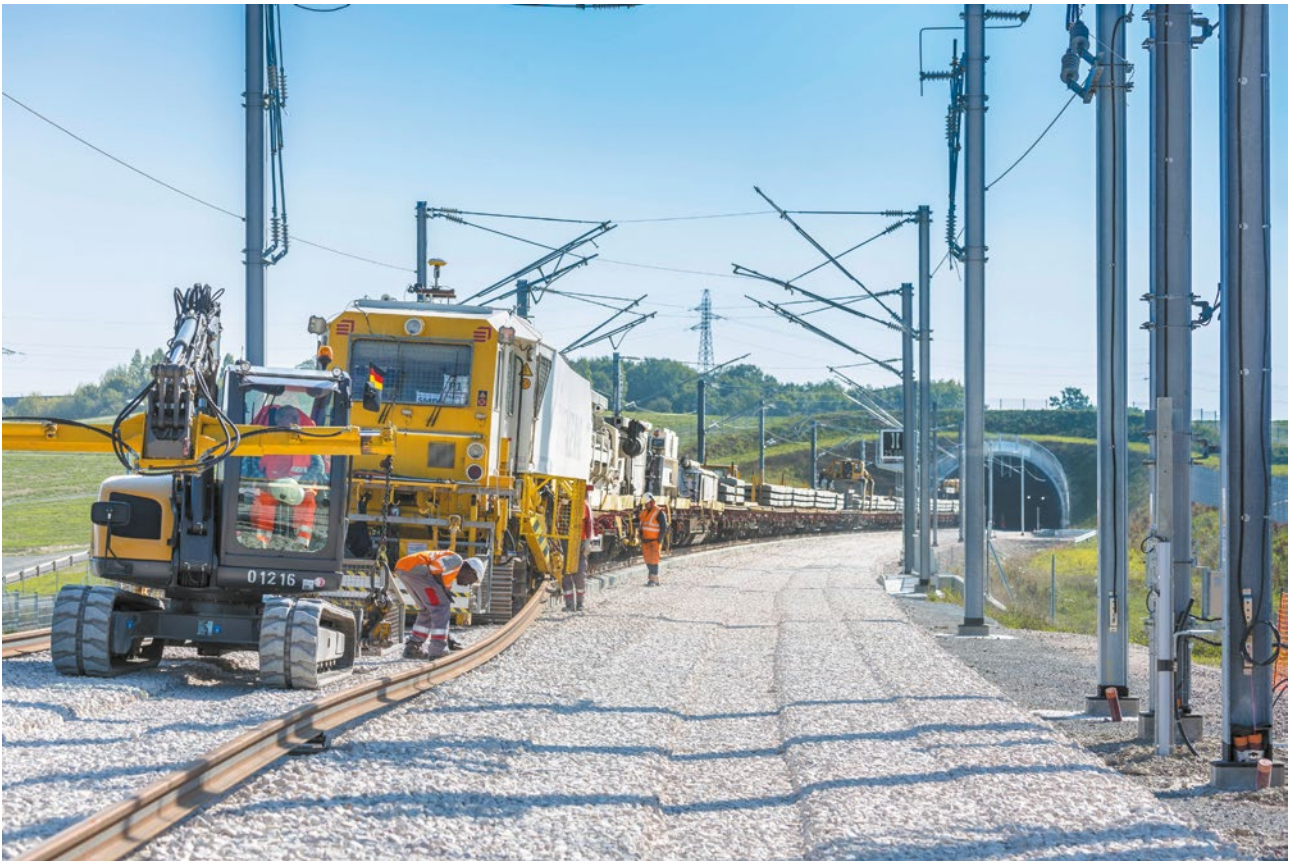
Le train de pose des rails sur la LGV Le Mans-Rennes
