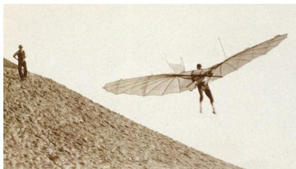
Le premier est un monoplane en bambou dont les ailes sont recouvertes de toile de coton. L'appareil fait environ 7 mètres d'envergure et pèse une 20aine de kilos. Pour faire ses sauts dans le vide, Lilienthal se fait élever un remblai de 15 mètres de hauteur.
