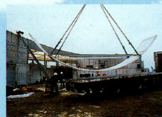
▲ Pose de la vitre en métacrylate (28 cm d'épaisseur pour un poids de 7 tonnes) de l'immense bac à requins.
