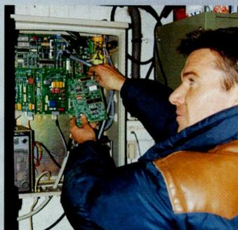
Une station automatisée : une boîte remplie de systèmes électroniques et équipée d'un système d'émission radio et téléphone et d'un capteur qui plonge dans l'eau. Un technicien du Sac travaille à temps complet sur l'entretien de ces stations.
