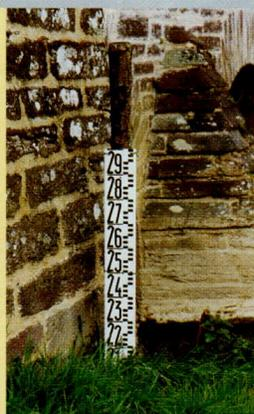
Une échelle limnimétrique. Les hauteurs sont exprimées en mètres et déterminées soit à partir du fond de la rivière, soit à partir du zéro de navigation (niveau minimum défini pour la navigation des péniches).
