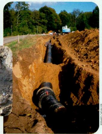
Une partie de l'alimentation en eau de la ville de Rennes provient toujours de l'aqueduc qui est régulièrement entretenu. Ici le remplacement des conduites d'origine par des tuyaux en fonte.
