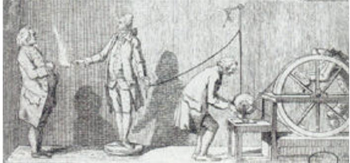
Il servait à isoler une personne du plancher. Quand la personne se trouvait sur l'un de ces tabourets et était en contact avec le conducteur d'une machine électrique, elle pouvait se charger électriquement : ses cheveux se dressaient alors dans l'air, elle pouvait enflammer de l'esprit de vin... En s'approchant d'une autre personne, elle pouvait aussi lui donner un « baiser électrique ».
