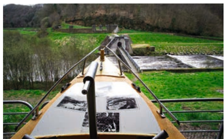
Des traces de l'ancien barrage de Kernansquillec, détruit en 1996, sont encore visibles.
