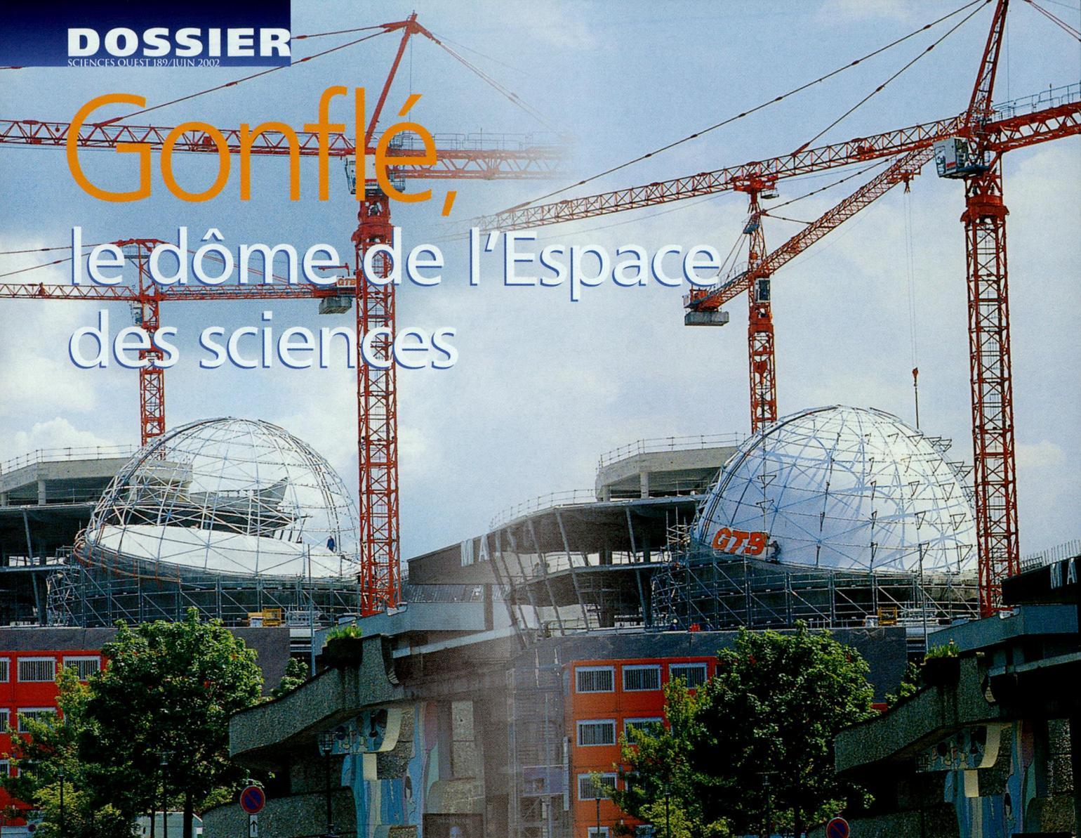
**L'** Espace des sciences se retrouve dans une structure géométrique originale : un "cône" surmonté d'un dôme dans lequel sera installé le planétarium. Planchers en lévitation, béton projeté, montgolfière, des techniques spectaculaires et innovantes.
