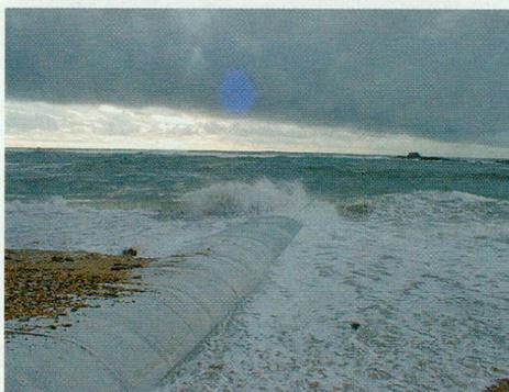
Les flux de sédiments sont régulés pour permettre de limiter l'érosion côtière. Au final, le Stabiplage sera entièrement recouvert de sable. Grâce à ce procédé, certaines plages du Morbihan ont pu être rehaussées de plus d'un mètre.
